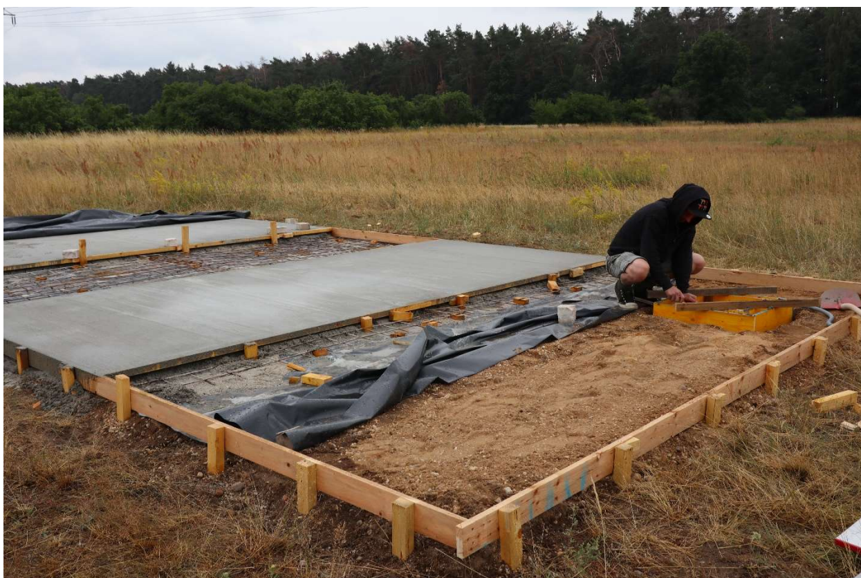
© Felix Pöchhacker, Vorbereiten und Gießen der Fundamentplatte Flur4
